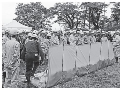
改良積み土のう工法
